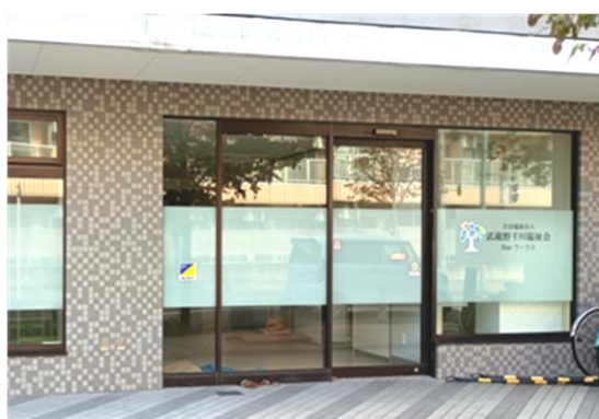
【内装工事が完成したBeeワークス(亜細亜大学通り沿い)】
